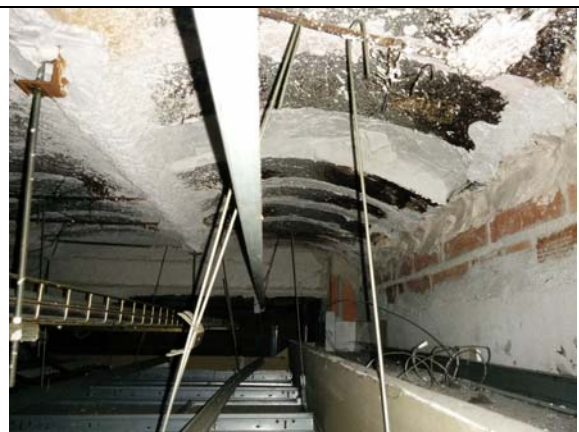
Sostre unidireccional amb protecció de morter
