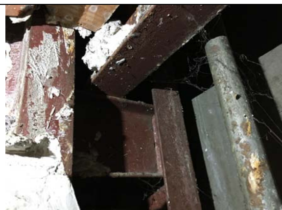
Recolzament jàssera amb pilar central
