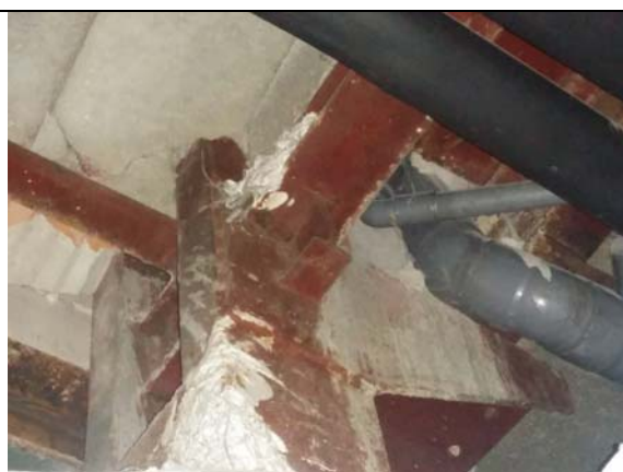
Unió pilar amb mènsula suport bloc 3 Recolzament jàssera amb pilar extrem
